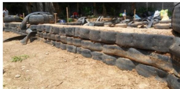
Figura 12. Estabilización de sobrecimiento con fajas de neumáticos
