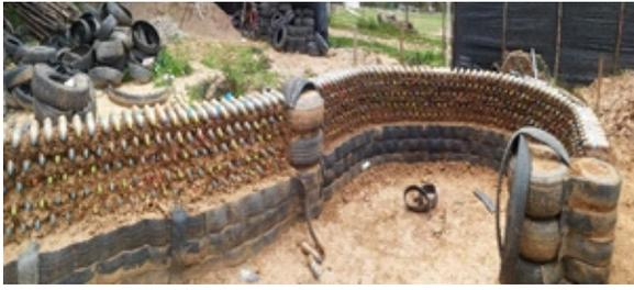
Figura 13. Muros con botellas pet
