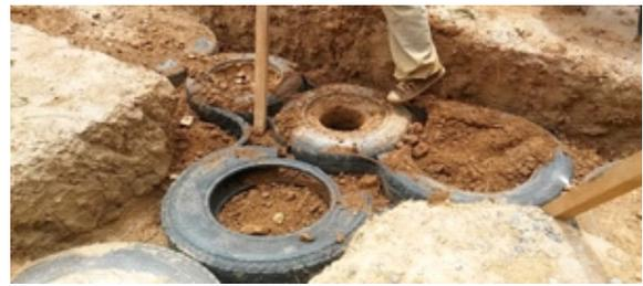
Figura 10. Estabilizando la cimentación con faja de neumáticos
