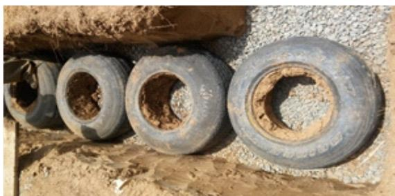
Figura 9. Cimentación con neumáticos de aro 16
